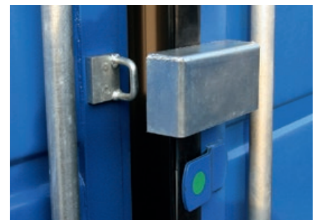
Einbruchsicherung montiert
