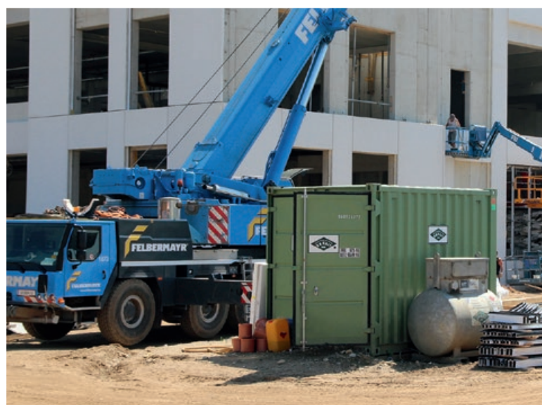
Einsatz auf der Baustelle
