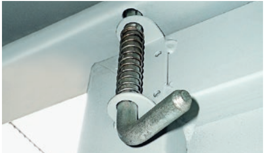
2 innenliegende verzinkte Verriegelungen
